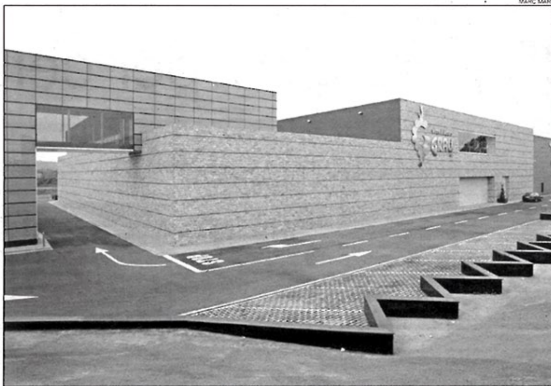
Noves instal·lacions. La nau industrial de Vins i Licors Grau destina 9.000 metres quadrats a magatzem.
